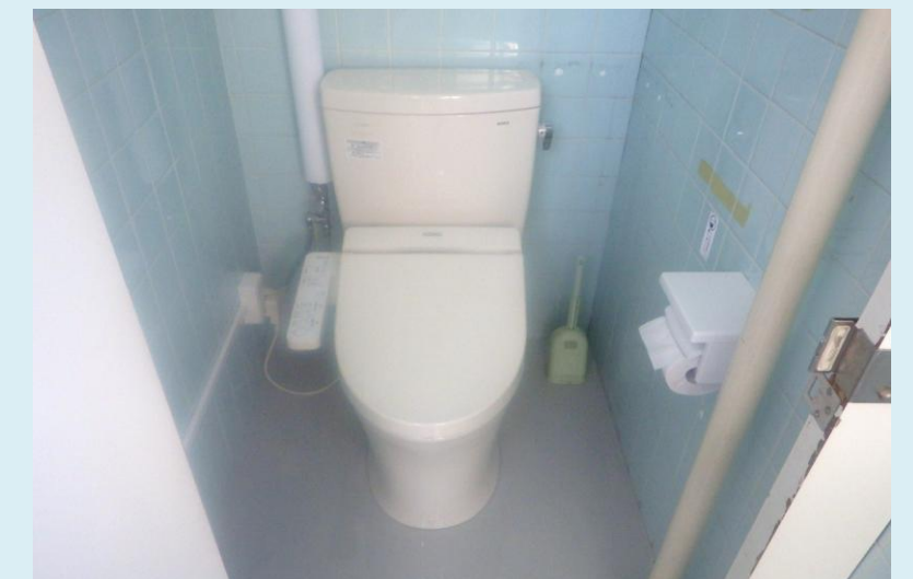
<写真の説明> 交換後の小便器・洋便器／床は防水塗装後の写真になります。
