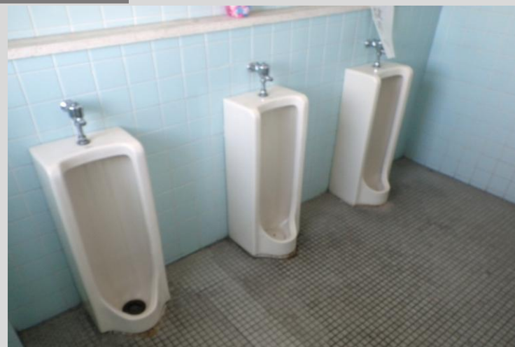
<写真の説明> 交換前の小便器・和便器／床も防水塗装前の写真になります。
